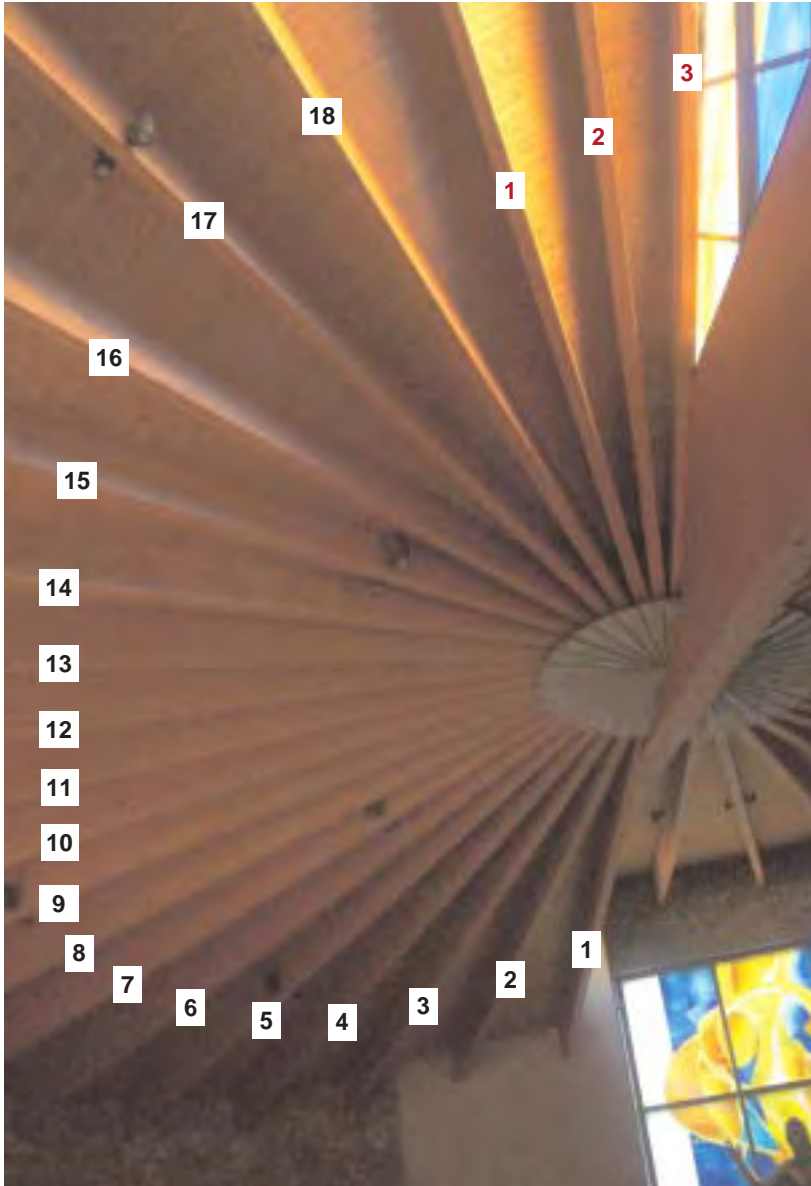
Ci-dessus: Vue des 18 poutres du côté gauche (en entrant par le portail de bronze) du plafond de la Salle Liturgique , plus les 3 dernières poutres qui se trouvent sur un plan incliné en direction du vitrail près de l'entrée. En haut à droite, on entrevoit le vitrail à 10 x 5 fenêtres, mieux illustré dans la photo en bas à gauche.
