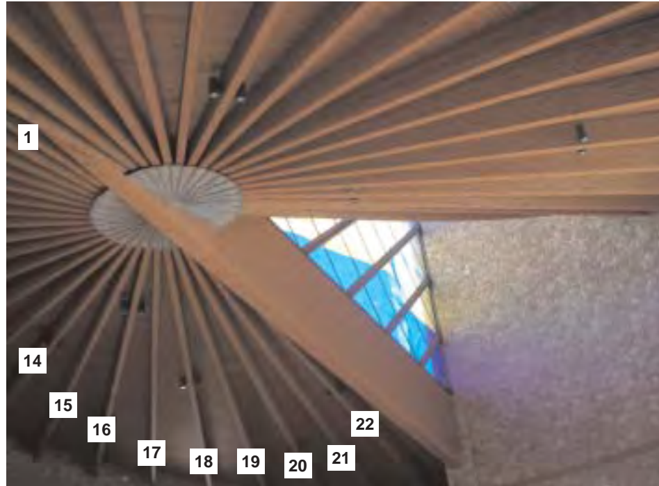
Ci-dessus: vue des 22 poutres du côté droit (en entrant) du plafond de la Salle Liturgique . Appuyé au mur d'entrée, on voit le vitrail à 10 x 5 fenêtres, mieux illustré dans la photo en bas à gauche.
